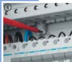
Простой демонтаж одного линейного защитного автомата из группы
